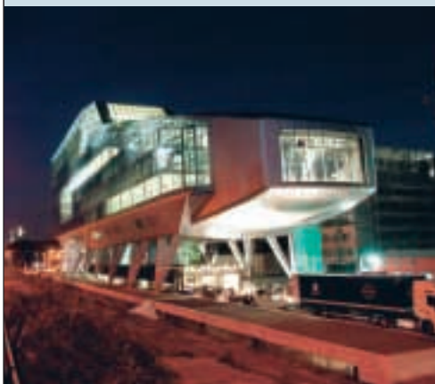
Op het hoofdkantoor van ING zitten ze niet te wachten op de problemen bij NMB-Heller
